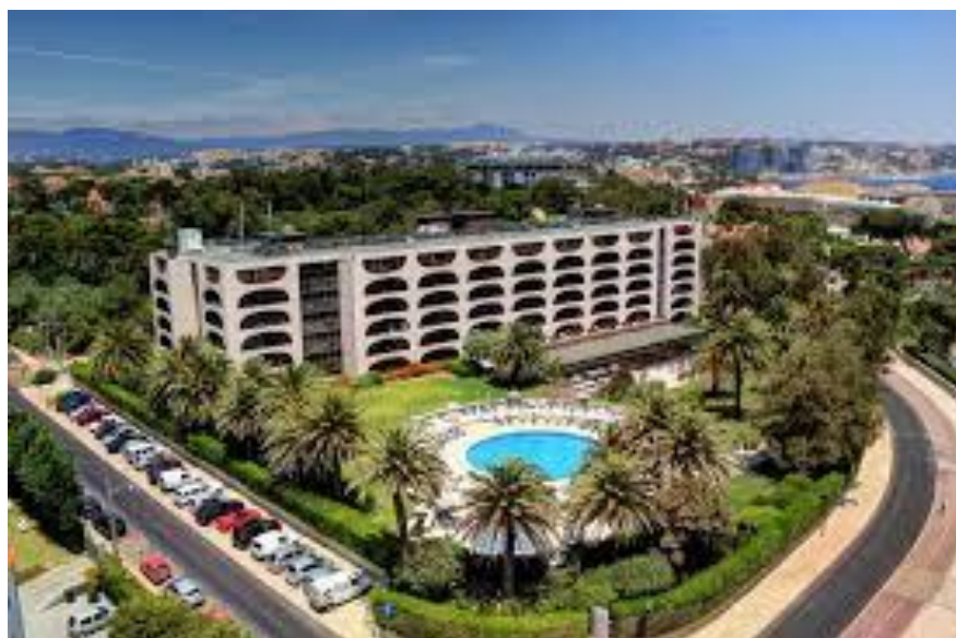
Hotel Vila Galé Cascais
